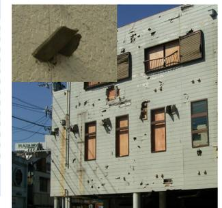
竜巻により屋根ふき材が飛来物として外壁に
