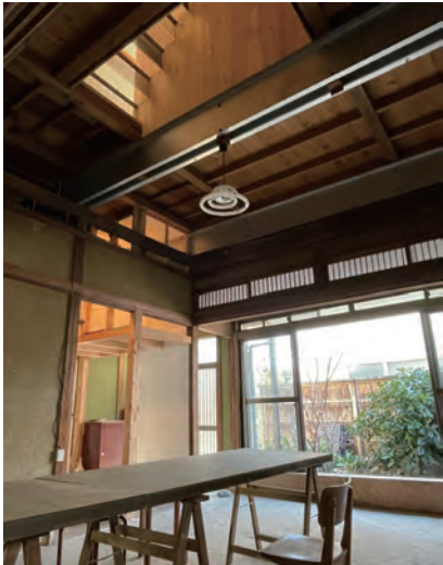
「(仮) 広瀬川コート・中澤庵」の三和土の土間。茶室だった時代の塗り壁や繊細な欄間、二階に改修時の補強の鉄骨など、歴代のリレーのバトンを大切に受け渡すようなデザイン
