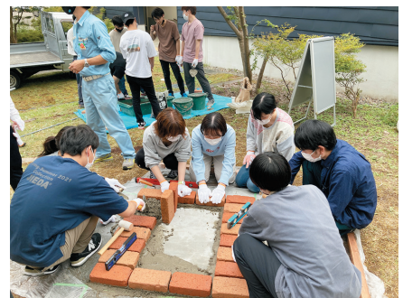
10 キャンパス内に制作したレンガの炉。コンクリートの打設やレンガ積みも企業と協力して学生が行った
