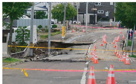
胆振東部地震での液状化被害②(札幌市)と斜面崩壊(厚真町)
