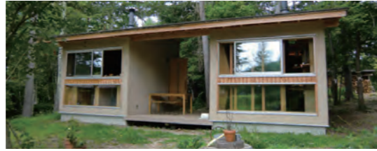
写真②:土壁と羊毛を組み合わせることで、断熱性能と蓄熱性能を兼ね備えた「現代版土壁」を実現(上)実験住宅、(右)模型
