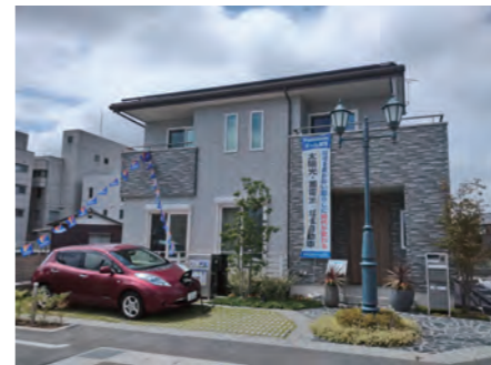
写真①:エネルギーの自給自足を目標とした太陽光発電・蓄電池・EV(電気自動車)を連携させた住宅の例
