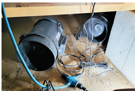
⑥ 床下への工業用ファンの設置
