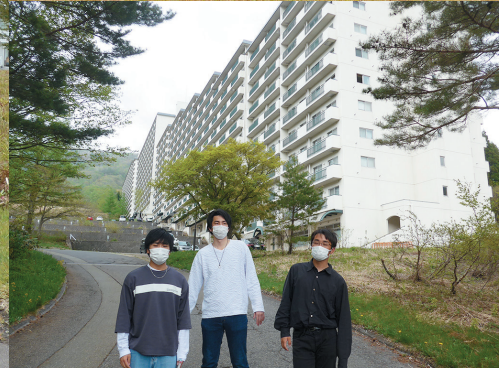
1～3 湯沢市のリゾートマンションの調査
