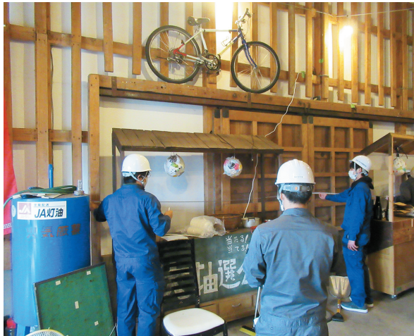
9 木造倉庫の現地調査の様子
