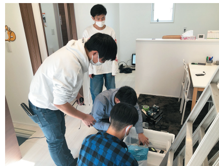
5 住宅センサ設置作業
