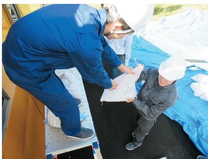
7 土嚢実験の準備。屋根に土嚢を載せている
