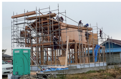
地域工務店の施工現場を調査
