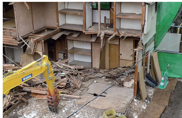
住宅の解体現場および建設発生木材を調査
